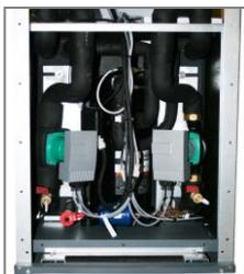
Das Wärmepumpenaggregat beinhaltet die gesamte hydraulische Technik. Die hier ebenfalls verbaute Kältebox, bestehend aus Kompressor, Wärmetauscher und Pumpen, ist gekapselt und beinhaltet einen „Silenter“ zur Schwingungsdämpfung. Dies gewährleistet geringe Betriebsgeräusche von ca. 44 dB (A) – 48 dB (A), modellabhängig.
