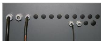
Die Einführung der Kabel für die elektrische Verdrahtung zur Wärmepumpe erfolgt durch die Öffnungen an der oberen Rückwand des Gerätes.
