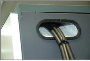
Die Einführung der Kabel für die elektrische Verdrahtung zur Wärmepumpe erfolgt über zwei Öffnungen an der oberen Rückwand des Gerätes. Die Kabel werden in einer Aussparung der Speicherisolierung zur Vorderseite des Gerätes geführt, wo sich ein Befestigungsblech zur Fixierung der Kabel befindet.
