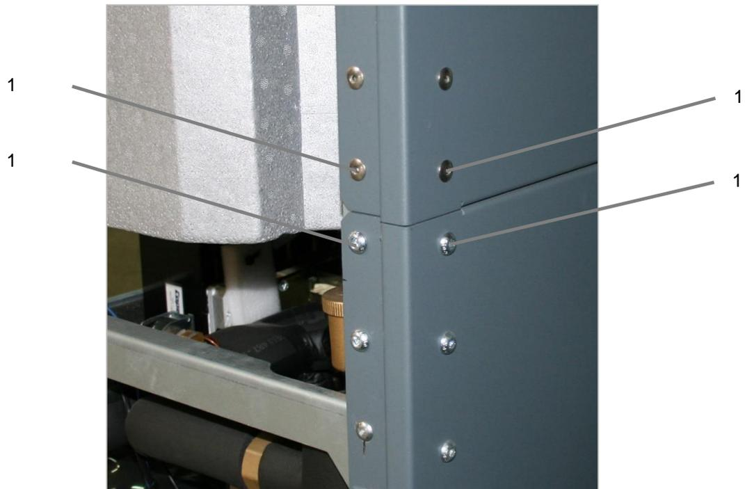
*Abbildung 4: Rückwand und Stahlprofile sind mit Linsenkopfschrauben (Pos. 1) gesichert*
