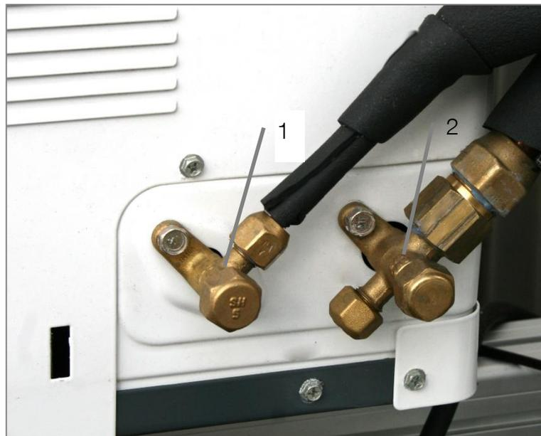
Abbildung 21: Kältemittelleitungsanschlüsse (Bördelanschlüsse) 1 – Flüssigkeitsseite; 2 - Gasseite
