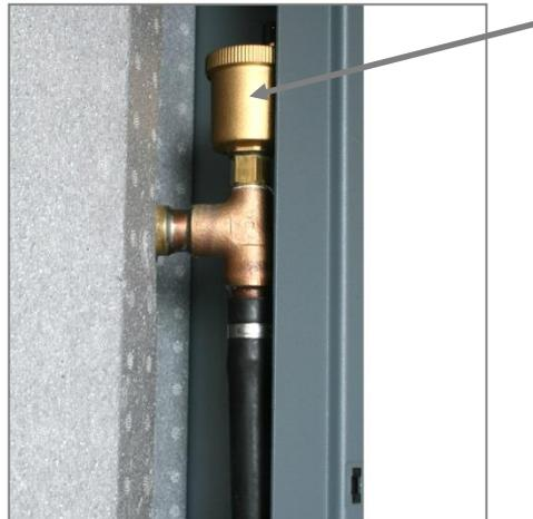
Abbildung 5: Speicheranschluss oben mit Entlüftungsventil
