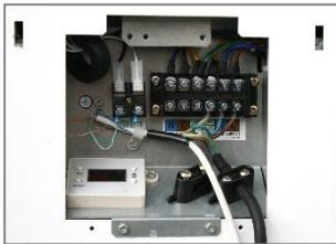
Zum Anschließen der Außeneinheit entfernen Sie die Abdeckung an der rechten Seite des Gerätes (siehe Kap. 8.4).
