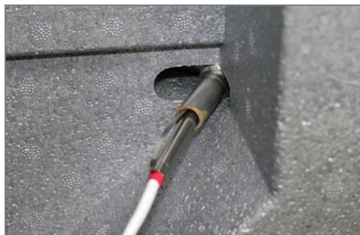
Abbildung 9: Tauchhülse mit Temperaturfühler am Edelstahlspeicher
