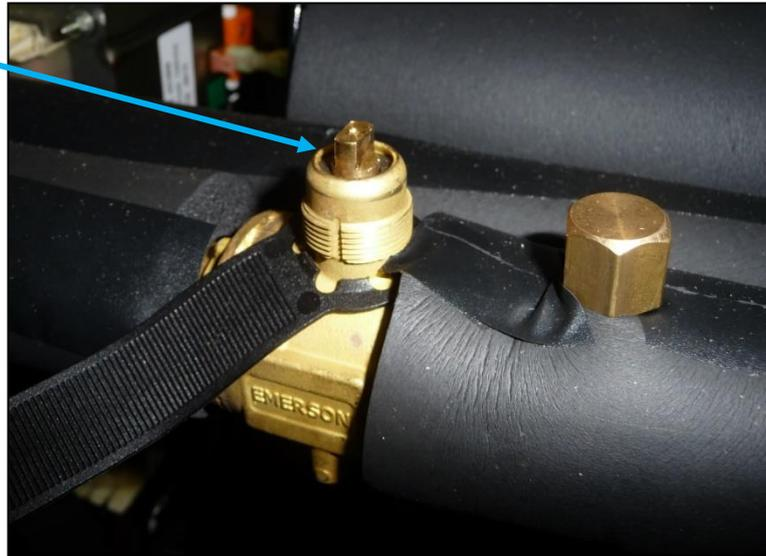
7. Nachdem beide Ventile vollständig geöffnet sind schrauben Sie die Schutzkappen wieder auf und ziehen sie fest (20 – 25 Nm).
