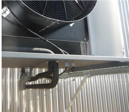
Abbildung 18: Kondensatablauf (Montage auf Wandmontageset)
