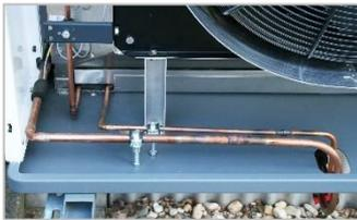
Die Kältemittelleitungen werden durch den Ausschnitt der Geräteunterseite in das Gerät geführt (siehe Foto).
