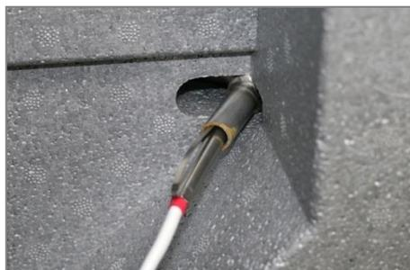
Abbildung 10: Tauchhülse mit Temperaturfühler am Edelstahlspeicher
