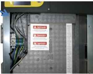
Die Anschlussklemmleiste der 230 V–Geräte wird am Grundrahmen (links) montiert, siehe Pfeil. Dazu wird vor der Montage der Isolierblock entfernt. Die Klemmenbelegung entnehmen Sie dem entsprechenden Schaltplan.
