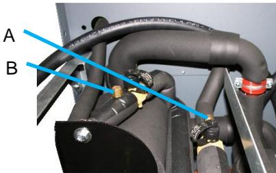
Vergewissern Sie sich, dass die Sperrventile geschlossen sind und öffnen Sie sie nicht.
