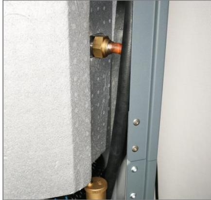
Abbildung 7: Speicheranschluss unten
