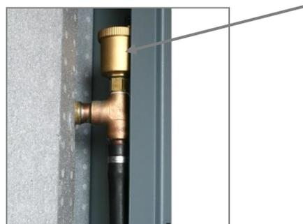
Abbildung 6: Speicheranschluss oben mit Entlüftungsventil
