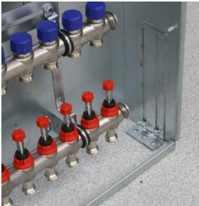
Stellen Sie das Höhenmaß mit Hilfe der verstellbaren Füße ein. Montieren Sie das Gerät mit den beiliegenden Halterungen in der Wand. Montagehöhe und Lochabstände entnehmen Sie der Zeichnung (siehe Abbildung 4).
